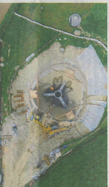
Ein Riesenkrauter: Die Baustelle für den Ringlaser zwischen Bruck und Alling. FOTOS: GEOHWSIKALISCHES INSTITUT
